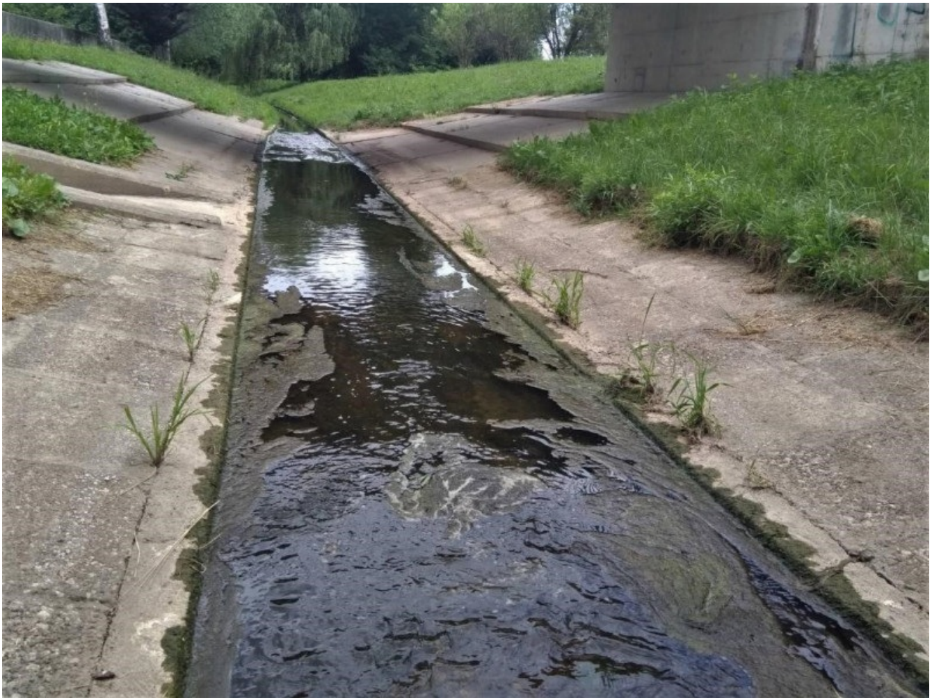
Veliko rek in potokov je spremenjenih v kanale; struga je izravnana, bregovi pa so utrjeni z betonom. Na fotografiji je primer potoka Glinščica v Ljubljani. Foto: Maša Zupančič
