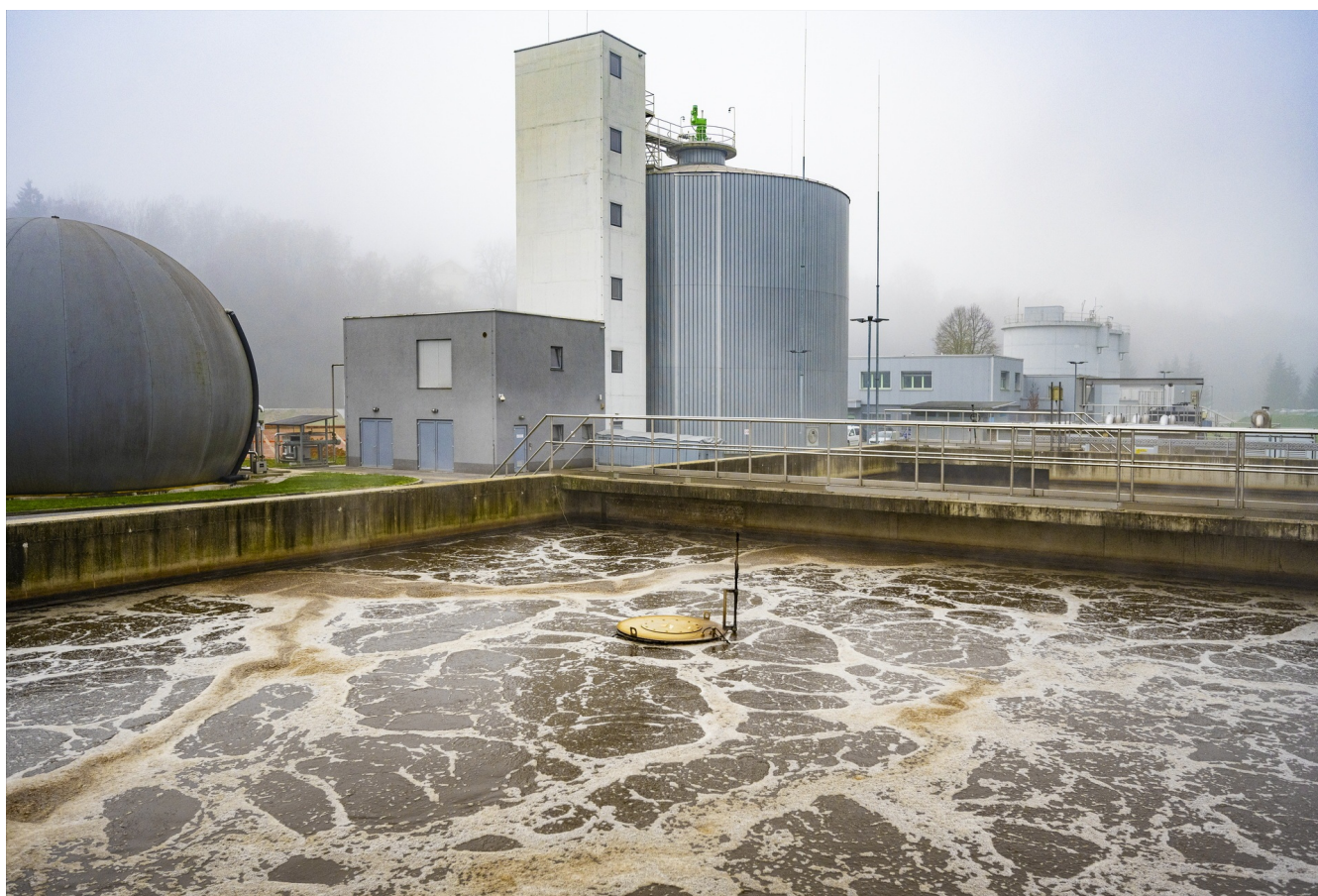
Čistilna naprava v Kranju, foto: Arne Hodalič
