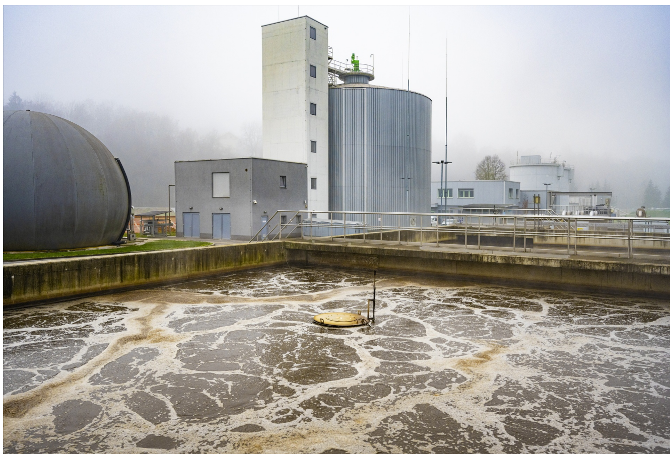
Čistilna naprava v Kranju, foto: Arne Hodalič
