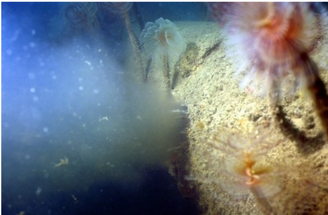
Slika prikazuje izpust odpadne vode iz podvodnega cevovoda čistilne naprave Piran. Centralna čistilna naprava Piran prečiščeno odpadno vodo odvaja preko dveh podvodnih izpustov dolžine 3600 m in 3450 m, ki imata na koncu difuzor. Foto: Tihomir Makovec
